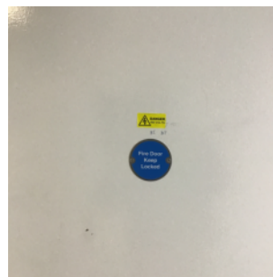
Example fire door signage.
